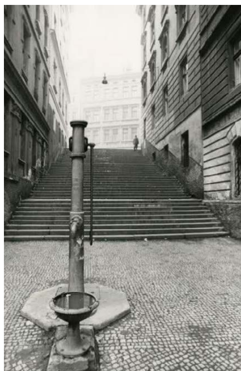
Původní ruční pumpa pod žižkovskými schody
